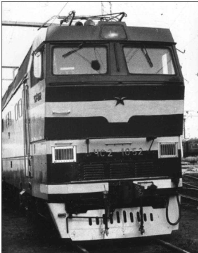
Испытание скоростемера СЛ-ЛИИЖТ на электровозе ЧС2Т-1052. 1982-83 гг.
