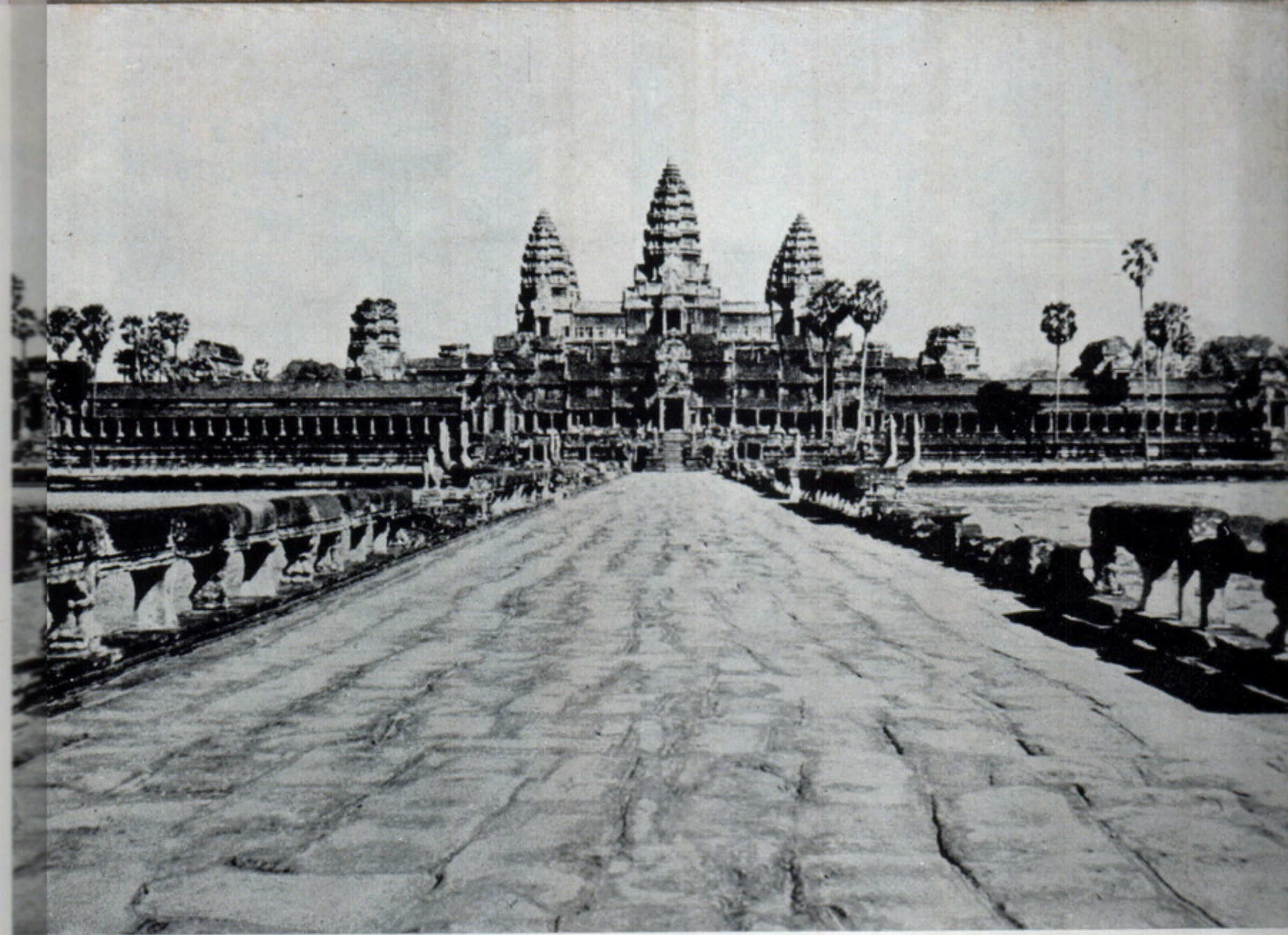
正面から見たアンコールワットの遺跡
