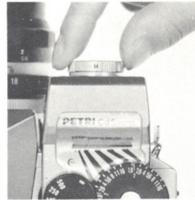
3. 明るい被写体なら感度切替リングをHに、暗い被写体ならLに合わせ（撮影時以外はOFF）、シャッターダイヤルを回し、希望の速度にセットし、メーター受光部を被写体に向け、メーター指針を読み取ります。
